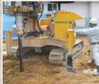
メーターサンブラー設置状況
